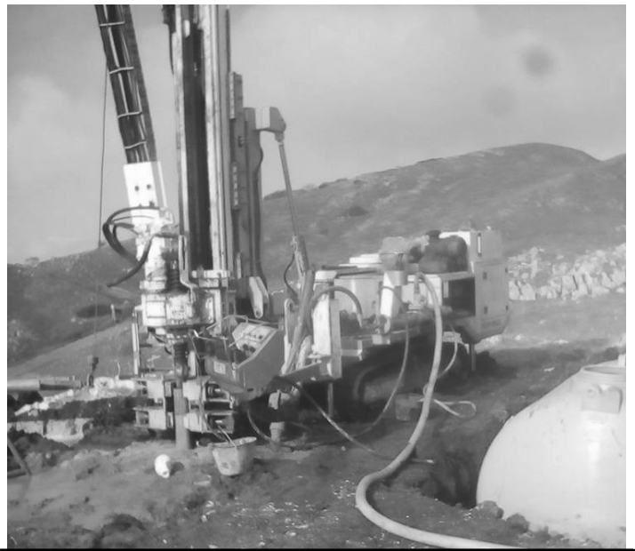
Trivella nel cantiere sulla montagna di Morcone
